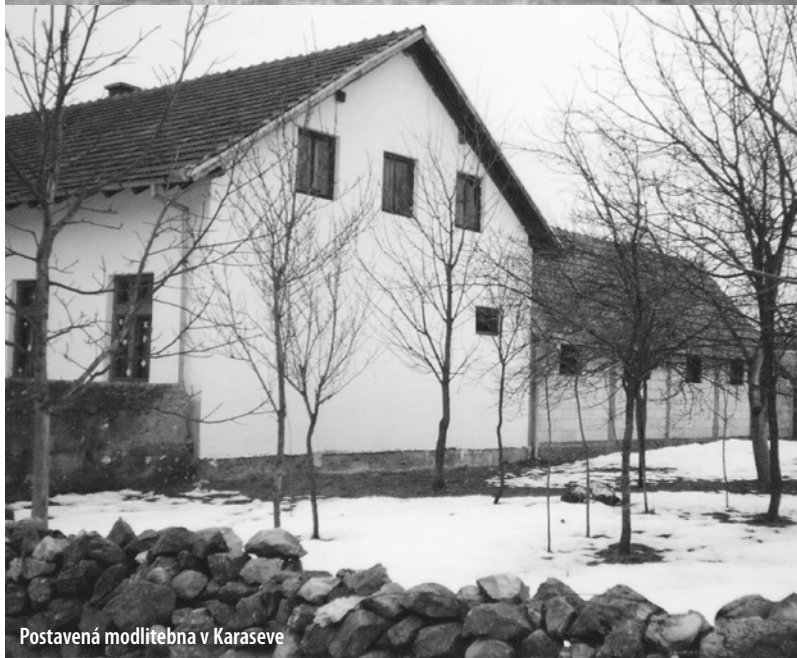
Stavba modlitebne v Karaseve
